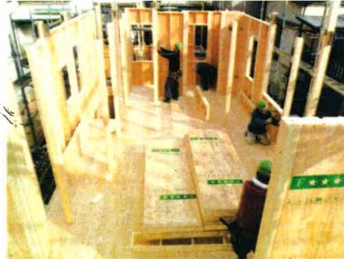
パネルは仮止めする、上部の梁を設置して、パネルを釘打ちする
