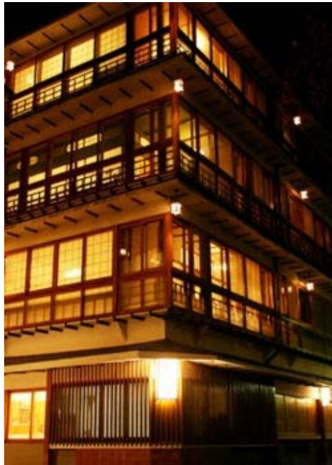
伊香保温泉 横手館（大正時代に建てられた）
