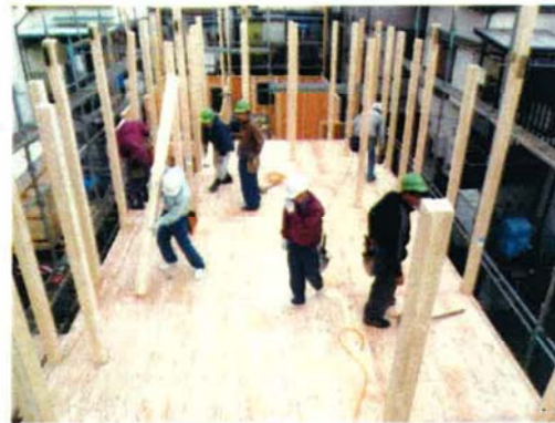
ホルダウンパイプで建て込む、ドリフトピンは後から
