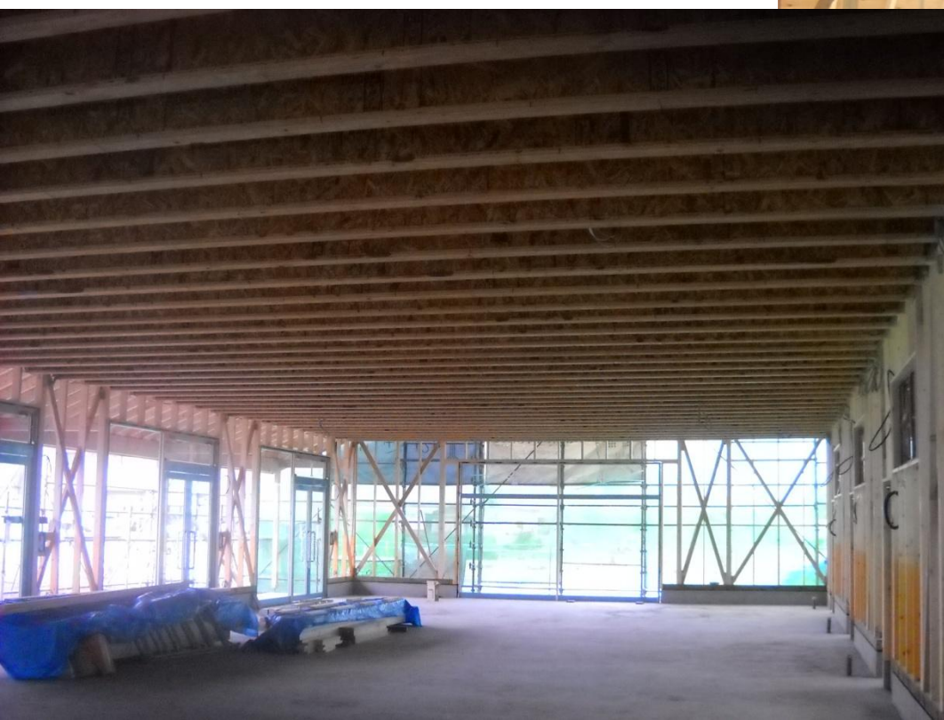
現場施工写真
