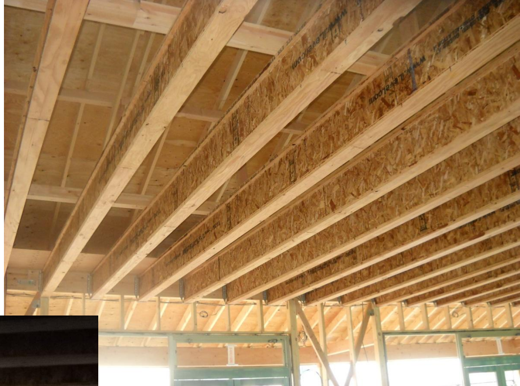
現場施工写真
